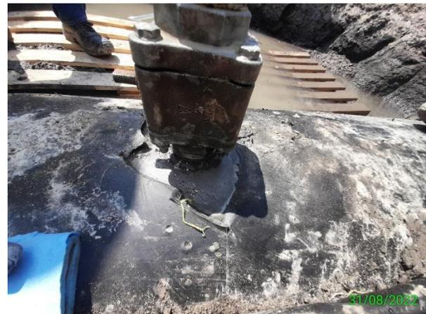
**31-Ago-22/15:10 hrs.:** el jefe mecánico realiza la limpieza y retiro del recubrimiento dejando el área lista para la aplicación de soldadura.
