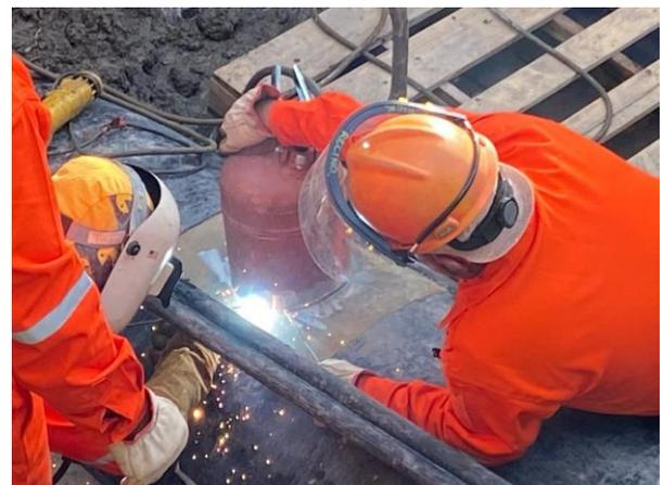
**1-Sep-22/20:31 hrs.:** Se dan por concluidos los trabajos de soldadura a tope para la colocación de carrete de 27 centímetros y tapón cap de 8 pulgadas sobre el arreglo de la toma clandestina - válvula de esfera de 2" pulgadas, notificando que se esperara a que se enfríe la soldadura para proseguir a las pruebas de líquidos penetrantes y posterior a esto la aplicación de Duc - Line como parte del recubrimiento.
