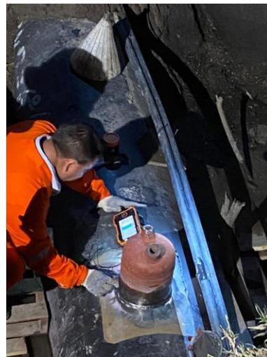
**1-Sep-22/21:35 hrs.:** Como método de seguridad y amortiguamiento de presión, se realizará el encapsulado del carrete CAP con resina de alta densidad.
