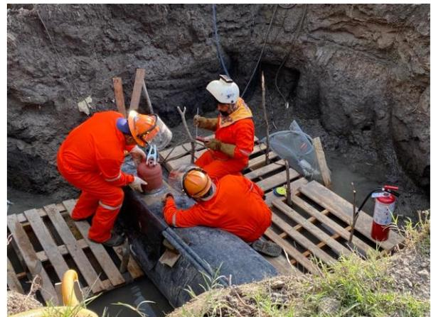
**1-Sep-22/18:35 hrs.:** Se comienza el procedimiento de soldadura a tope, considerando los 4 pasos marcados en el procedimiento del contratista y soldador certificado (Fondeo, Paso Caliente, relleno y Vista)
