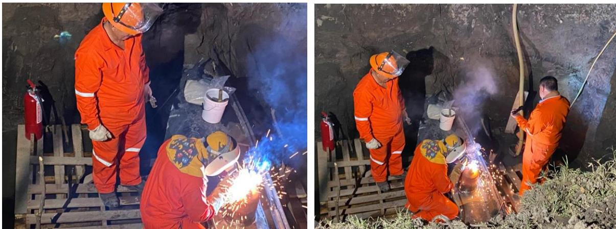
**1-Sep-22/17:26 hrs.:** Se procede a la aplicación de recubrimiento de polímeros base petróleo (Duc-Line) para reponer el recubrimiento del tubo y el carrete tipo CAP.
