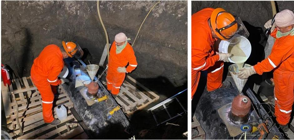
**1-Sep-22/ 22:10 hrs.:** Se procede a poner tapones NPT en los puertos de inyección y muestreo.
