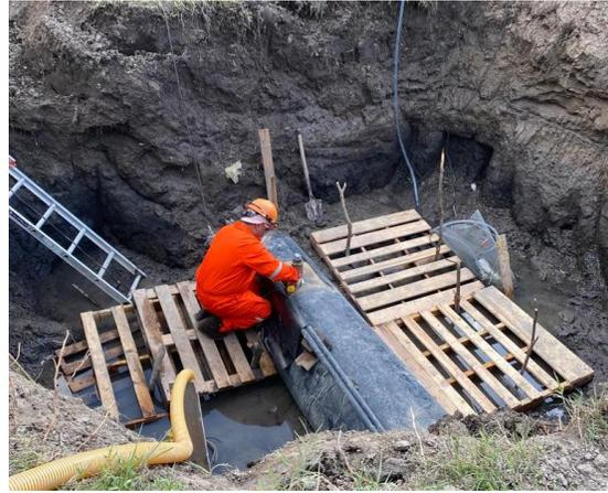
**1-Sep-22/18:27 hrs.:** Se inician los trabajos de soldadura y punteo para del carrete cap de 27 centímetros de largo y tapón cap de 8 pulgadas.
