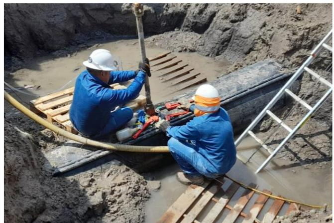
**31-Ago-22/13:50 hrs.:** Se realiza mantenimiento básico y limpieza a la válvula existente de raíz.
