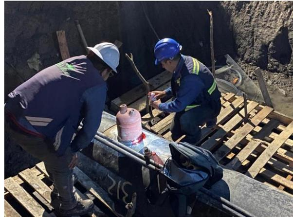
**1-Sep-22/21:10 hrs.:** El laboratorio dictamina que la soldadura es **APROBADA** por el método y procedimientos correctos, queda pendiente entrega de los originales del reporte.
